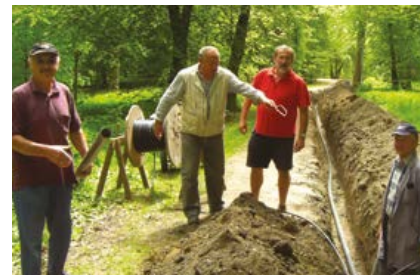
Kabelverlegung für die Parkbeleuchtung
