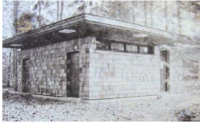
Geräteraum und Toilettenanlage 1979
